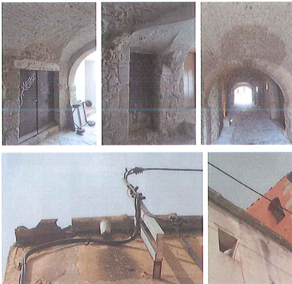
CARRER CÀCUL: DETALLS ARQUITECTÒNICS, ESTAT DE CONSERVACIÓ
